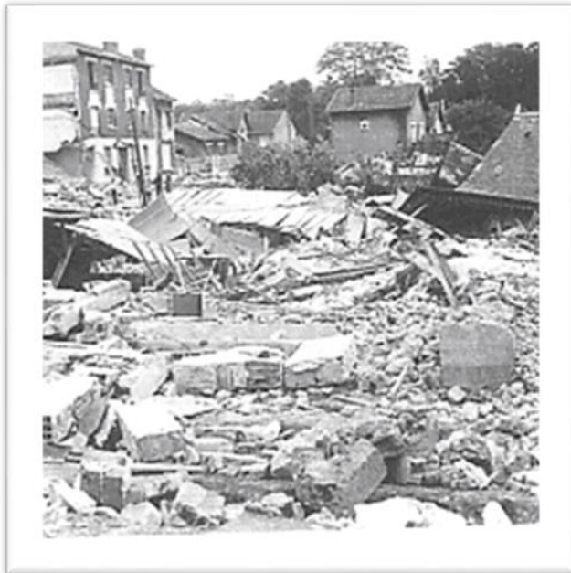
Effondrement d'une carrière de craie sur le territoire de Clamart et Issy-les-Moulineaux
